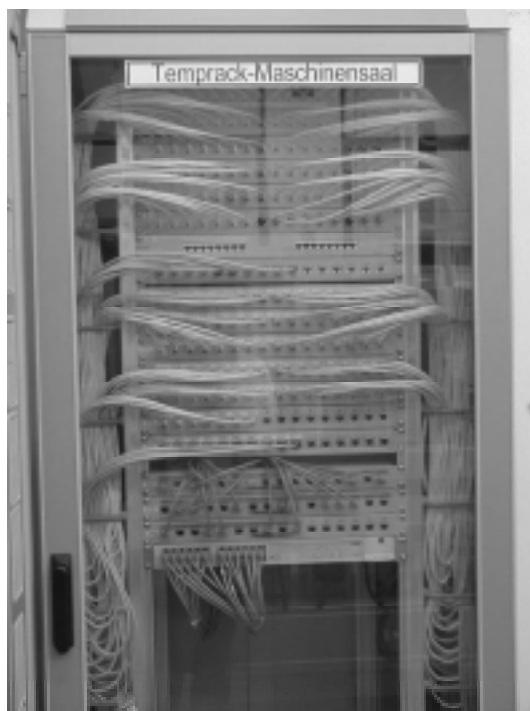
Verteilerschrank für Netzanschlüsse
