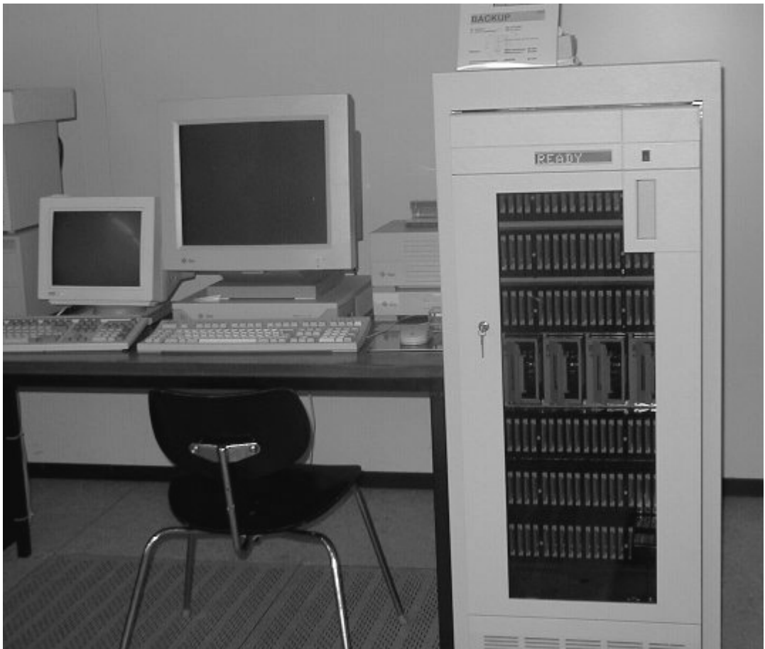
Backup-Server mit Exabyte-Roboter (120 Kassetten)
