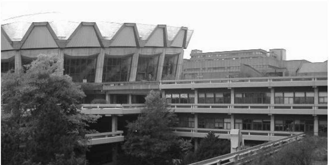
Südansicht der Rechenzentrumsräume mit AudiMax
