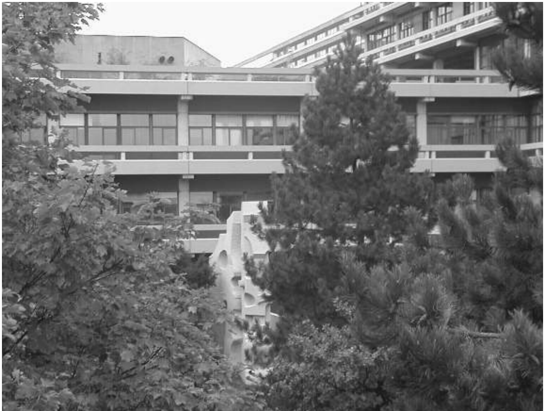
Südansicht der Rechenzentrumsräume
