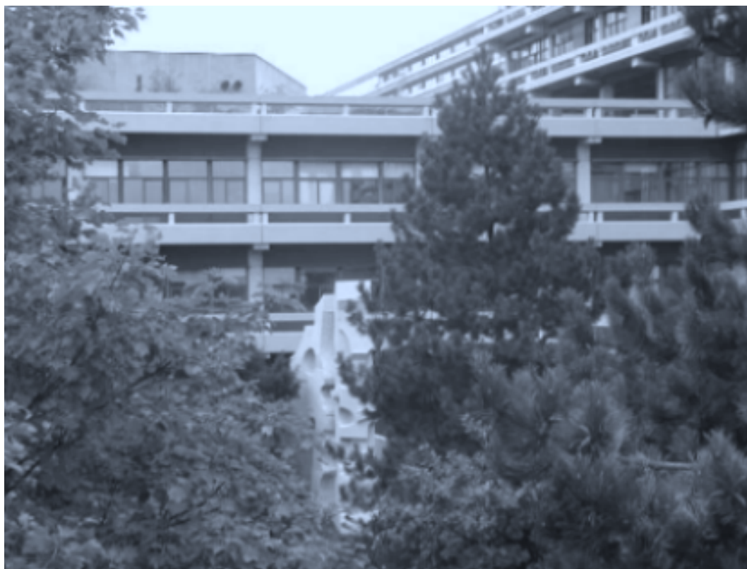
Südansicht der Rechenzentrumsräume
