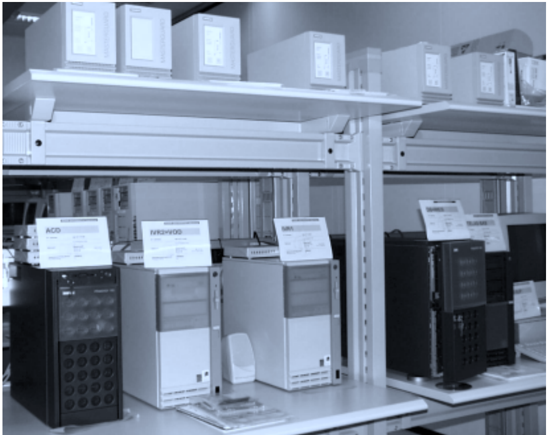
Server für neue ISDN - Telefonanlage
