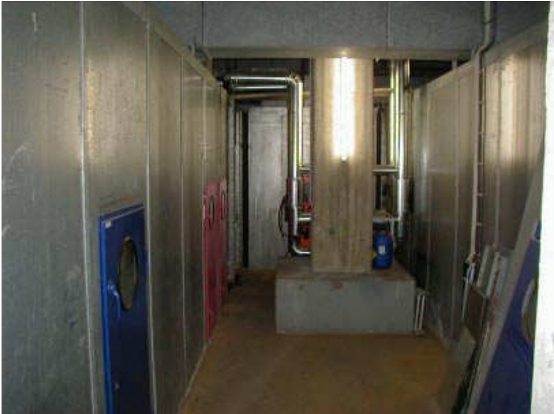
In der Klimaanlage des Rechenzentrums
