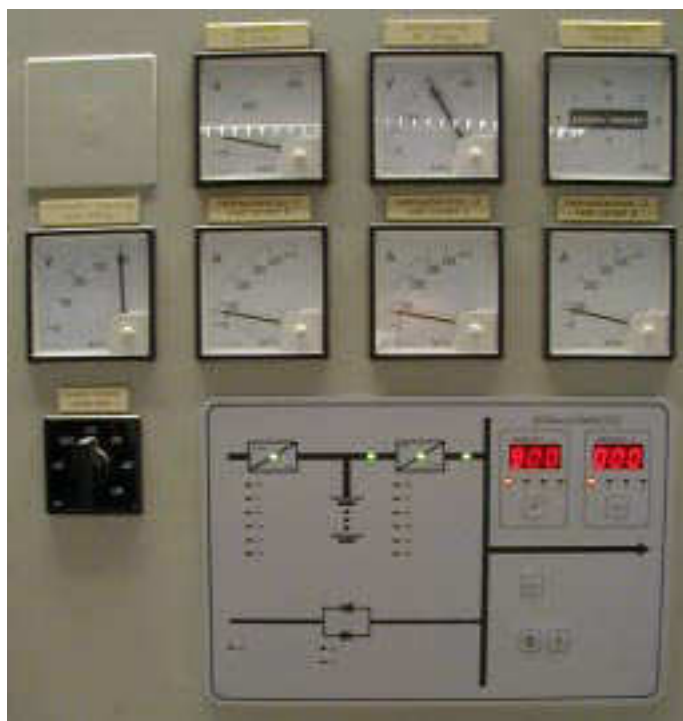
Wechselrichter-Steuerung für die Stromversorgung des Rechenzentrums
