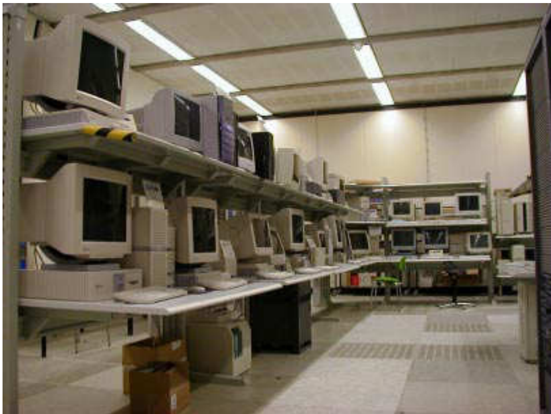
Historisch gewachsener Server-Zoo im Rechenzentrum
