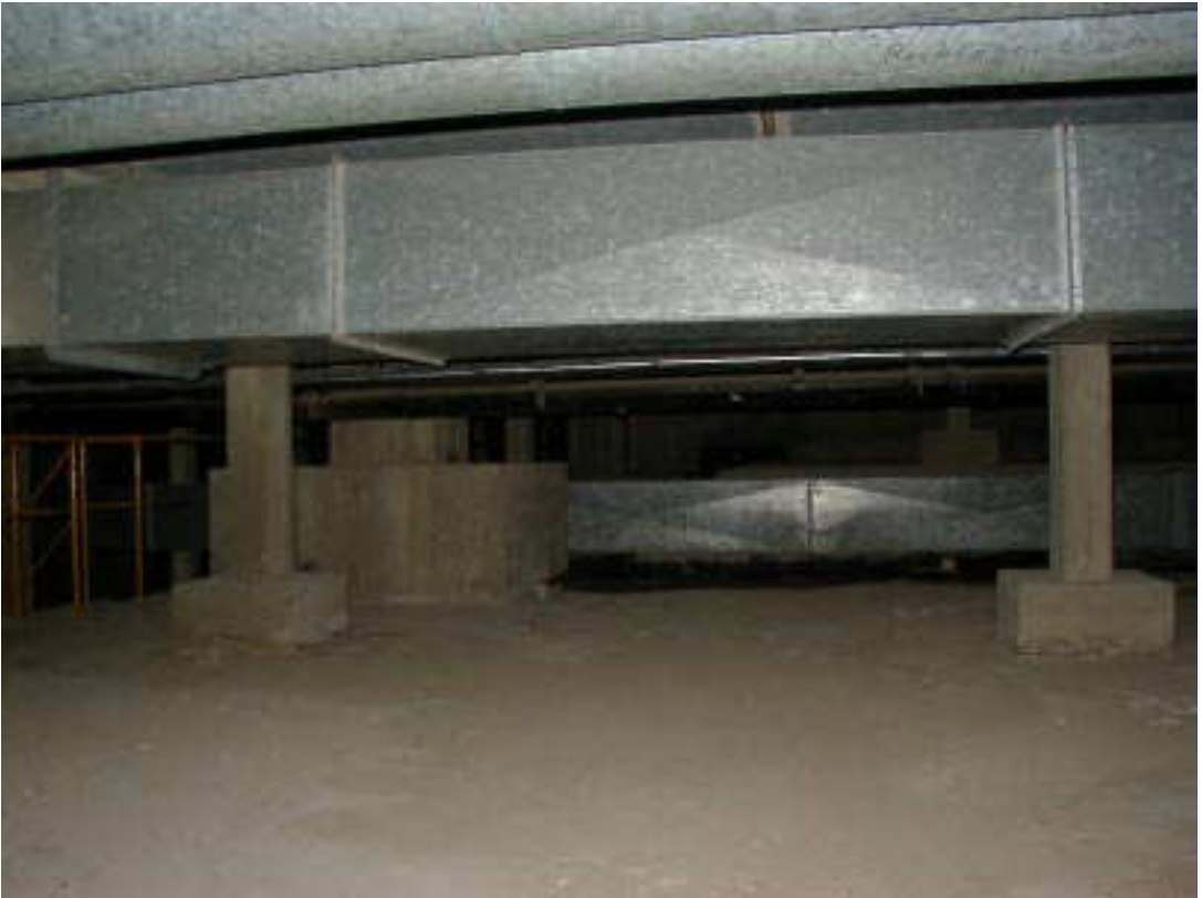
Die Keller der Ruhr-Universität: Kriechgänge für Kabelkanäle und Versorgungsleitungen
