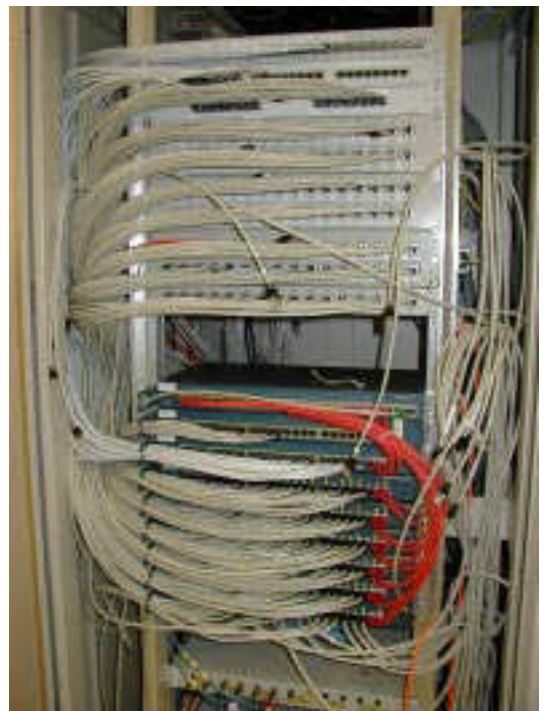
Switches des hochschulinternen Rechnernetzes
