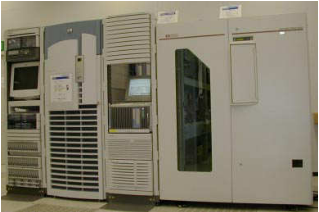
SAN, SuperDome und Backup-Server mit Magnetkassetten-Roboter
