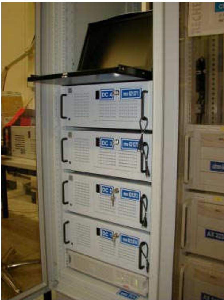
Platzsparende Rackbauweise für Intel-Server
