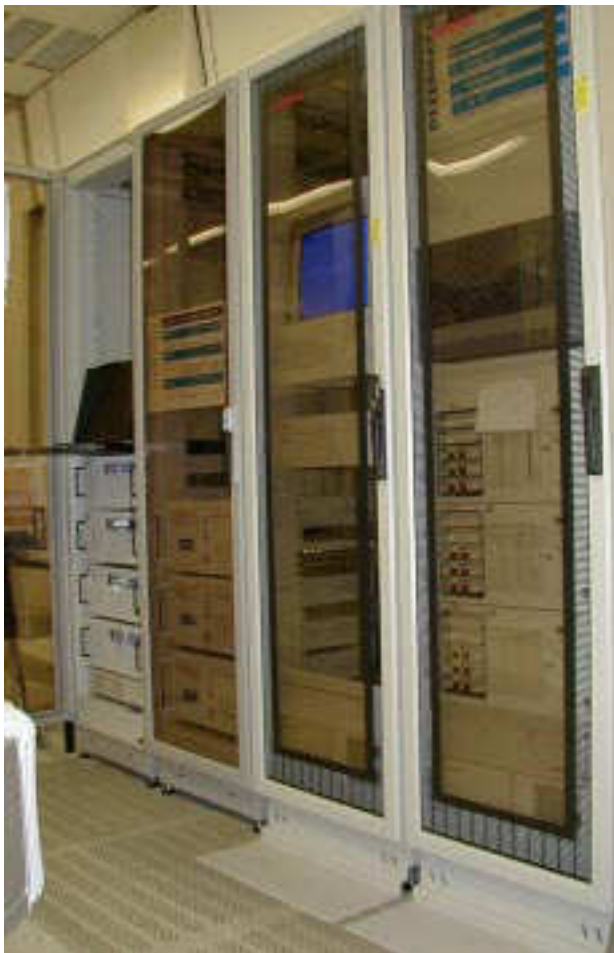
Intel-Server-Aufstellung in Regalbauweise
