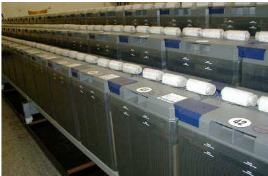
Batteriepufferung für die Stromversorgung des Rechenzentrums
