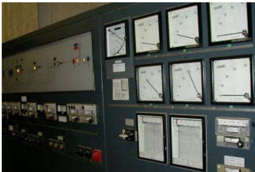
Steuertableau für die Klimaanlage
