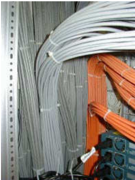
Kabelbäume des Rechnernetzes
