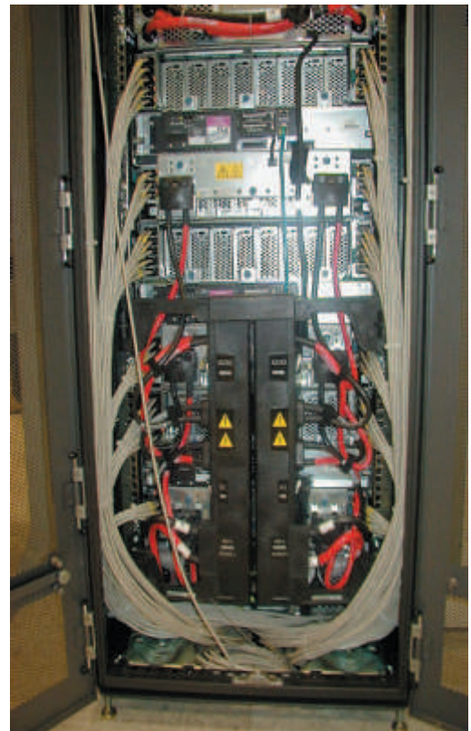
Serverblades: redundante Stromversorgung
