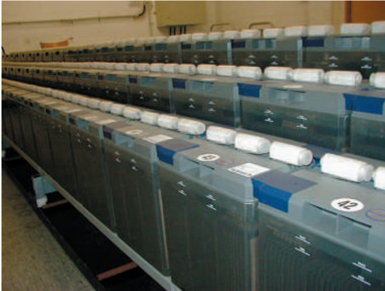
Sicherheit: Batteriepufferung für die Stromversorgung des Rechenzentrums
