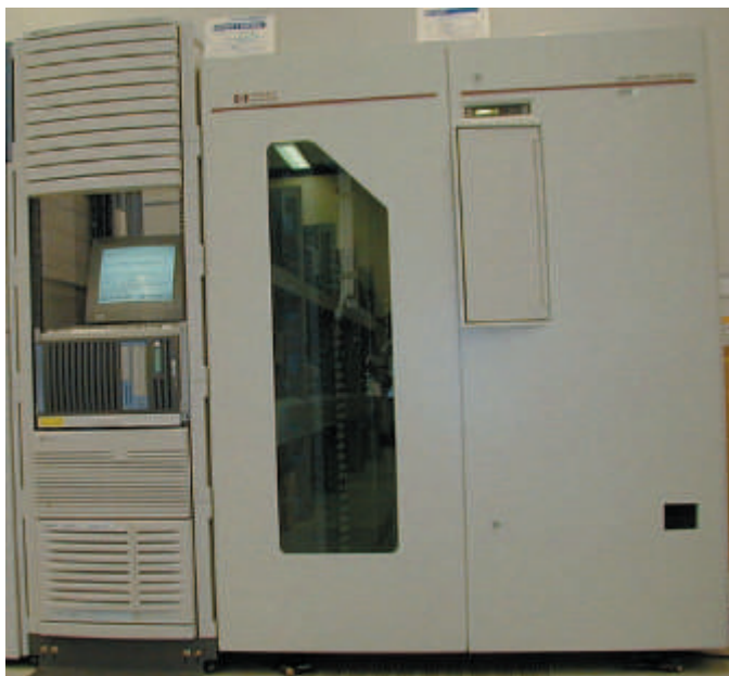
der zentrale Backup-Server
