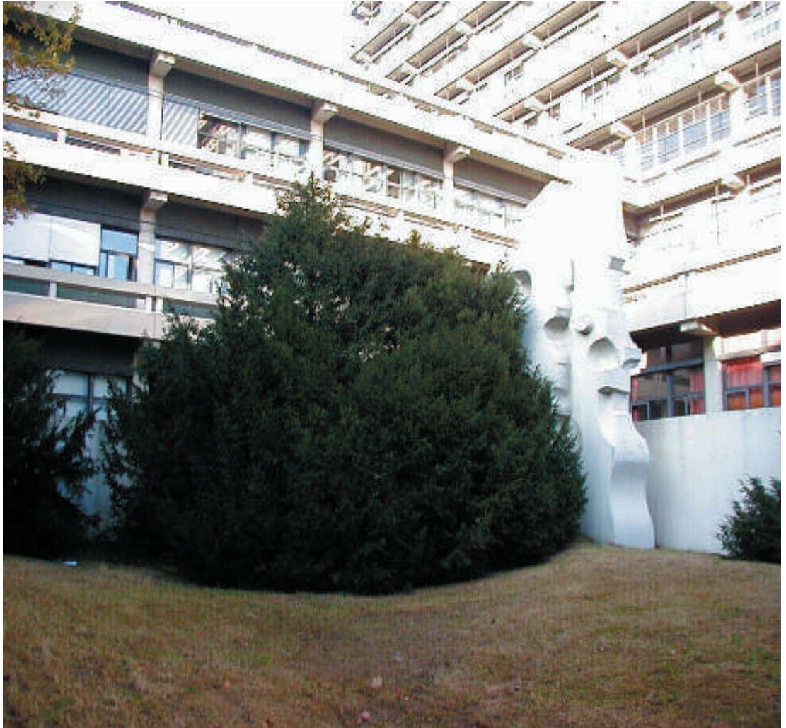
Blick auf die Rechenzentrumsräume vom Lichthof NAF aus
